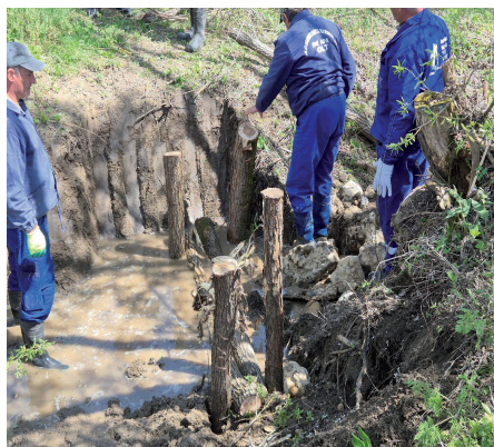
Fotografie realizată de Bencze Szilvia. Construirea de baraje din bușteni întărite cu pietre de către Direcția Apelor Olt pe pârâul cadastrat din Daia. Micul pârâu a umplut albia pârâului într-o singură zi.
