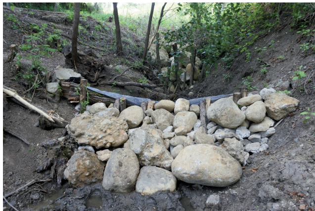
Fotografie realizată de Bencze Szilvia. Combinație de dig din piatră și bușteni, Daia
