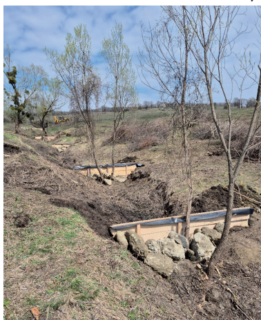
Fotografie realizată de Bencze Szilvia. Praguri de fund realizate din scânduri de stejar de 5 cm, Petecu
