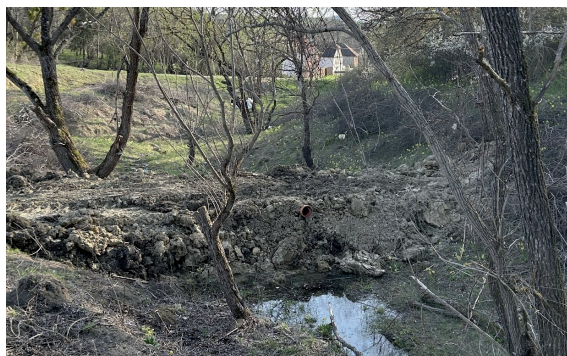
Fotografie realizată de Both Tünde. Baraj de pământ cu canal de scurgere, Petecu
